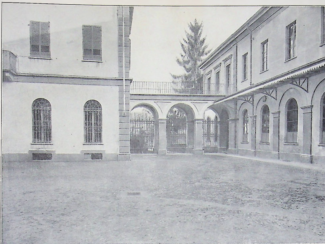
CORTILE : Uno degli ingressi laterali.
